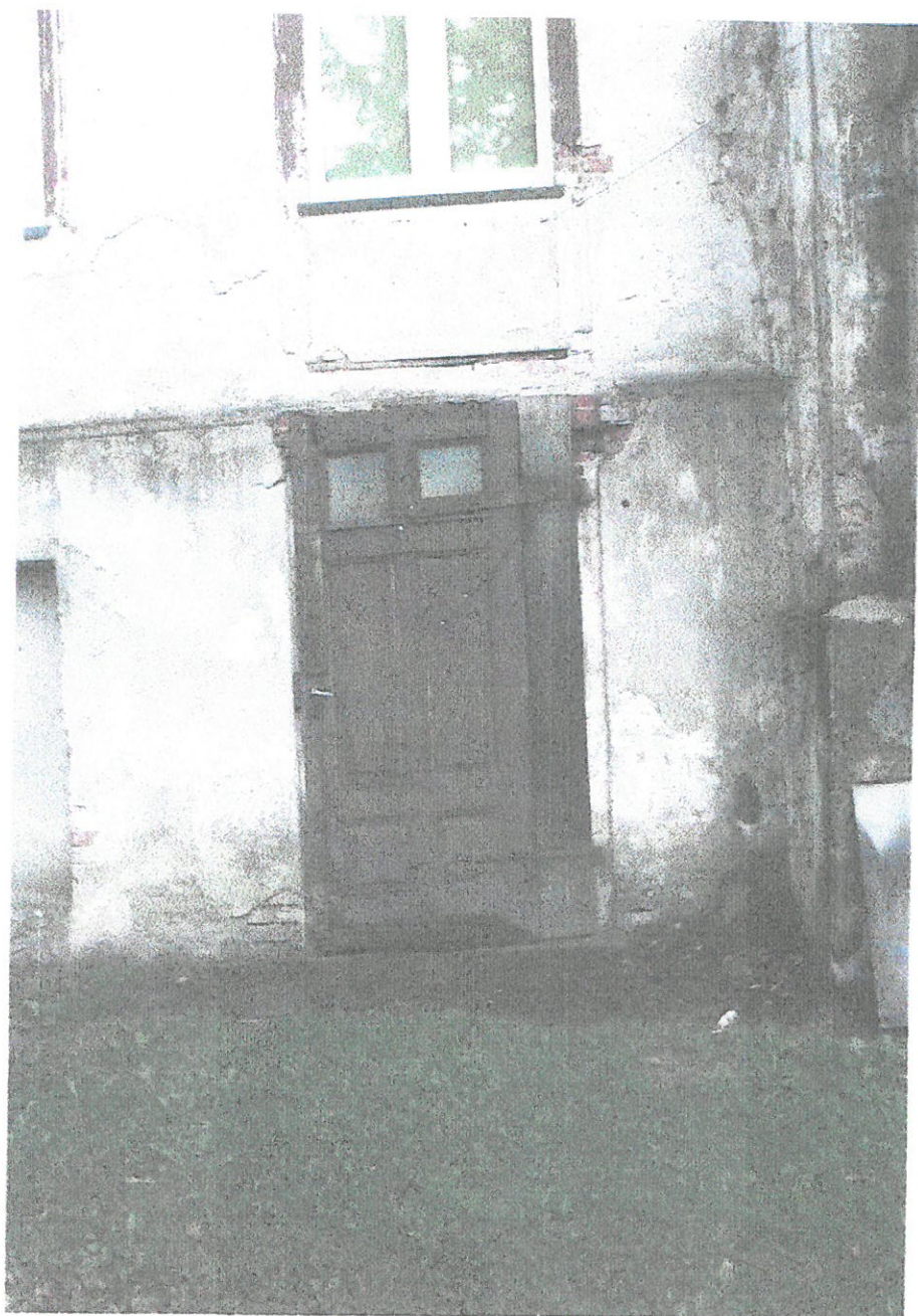
Wejście do piwnicy
