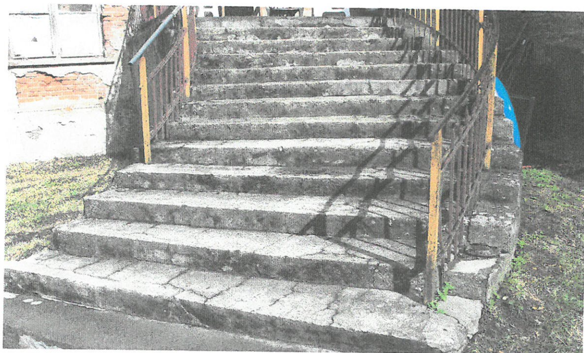
Spękana powierzchnia stopni od strony podwórza
