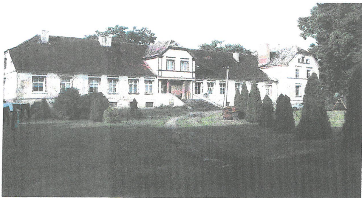
Elewacja frontowa północna
