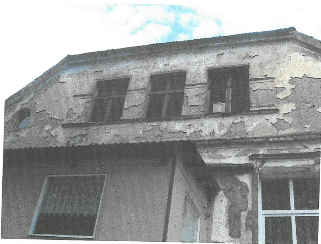
Okna poddasza nadające się do renowacji
