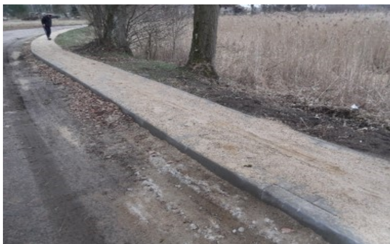
Budowa chodnika w miejscowości Młodawin
