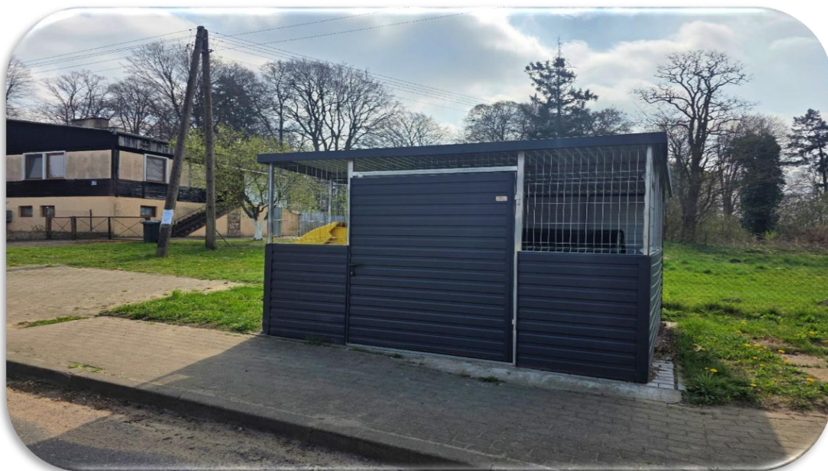
Zakup wiat śmietnikowych i utwardzenia terenów pod wiatami Sołectwo Rekowo
